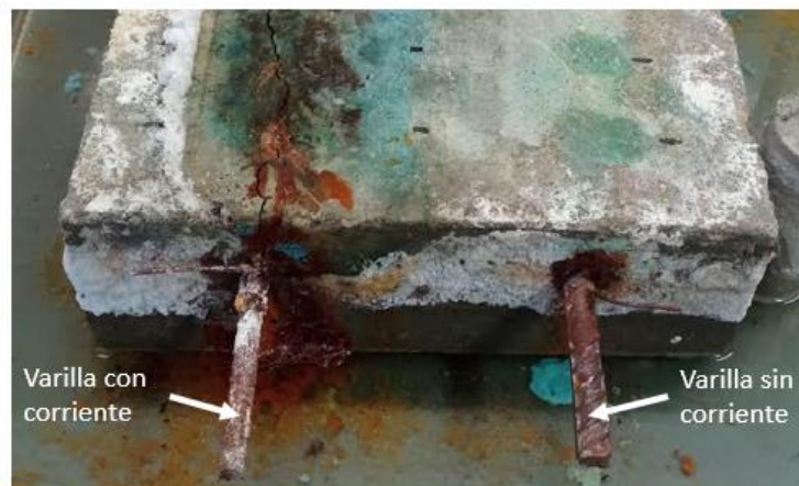
Figura 10. Losa de concreto sometida al proceso de corrosión acelerado.
